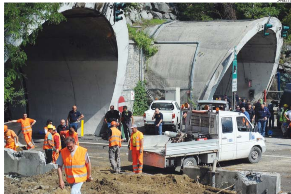
Alta velocità. Mentre il movimento No Tav continua a opporsi alla costruzione della linea ad alta velocità fra Torino e Lione, a Chiomonte (Torino) in Val di Susa sono aperti i cantieri per la costruzione del primo tunnel esplorativo del nuovo collegamento ferroviario
